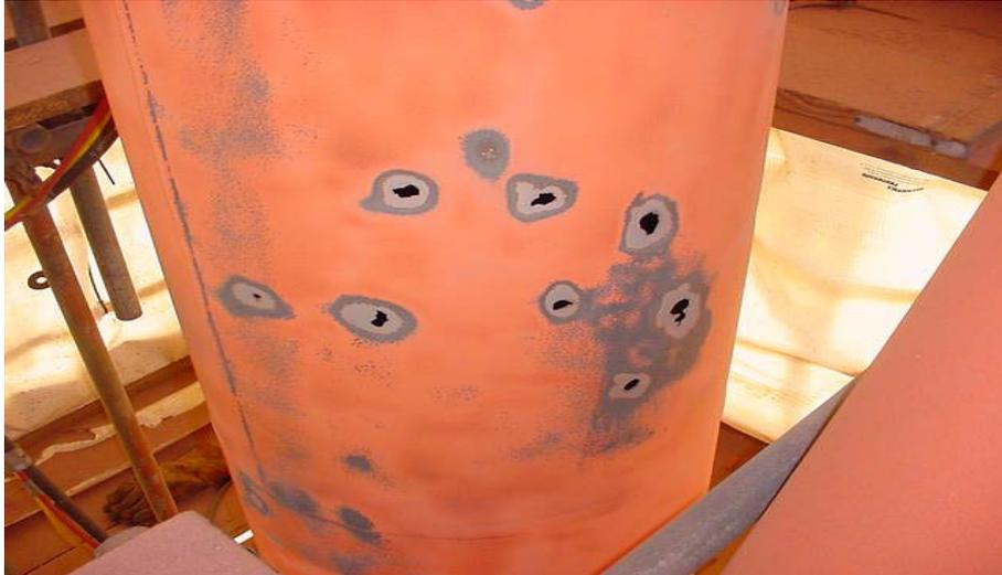
Figura 10 - Tubulação fora de operação sendo preparada para o reparo
