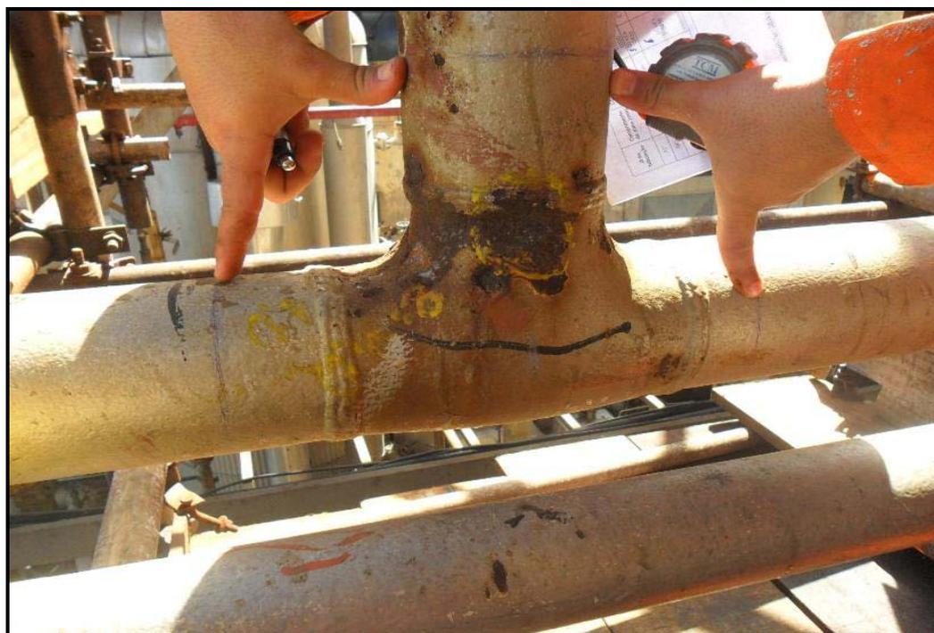
Figura 5: reparo em geometria T em trecho da tubulação com perda de espessura externa.
