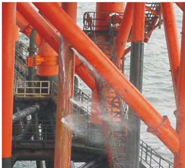
Figura 9 - tubulação apresentando vários vazamentos.
