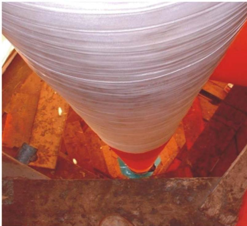
Figura 11 - Reparo executado em toda a área comprometida restabelecendo assim a operação na tubulação.
