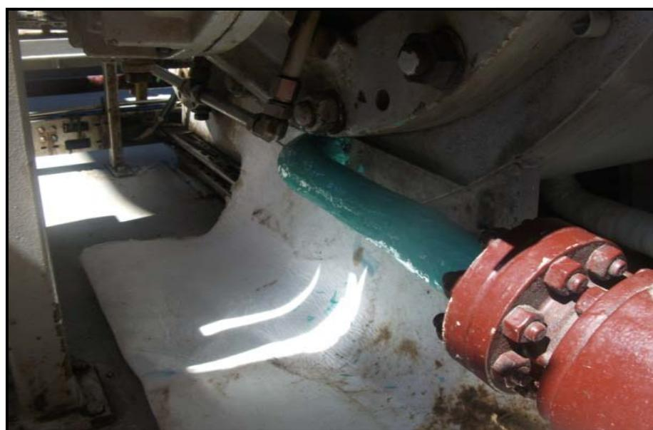
Figura 3 - Aplicação de resina para recompor a geometria do substrato
