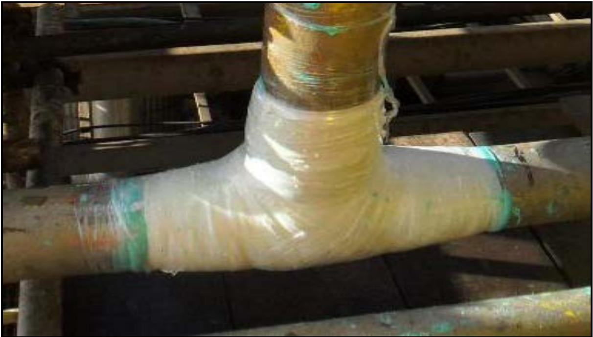
Figura 8 - Aplicação da fita de fibra de vidro pré-impregnada e da fita de compressão e mais um reparo concluído com sucesso.
