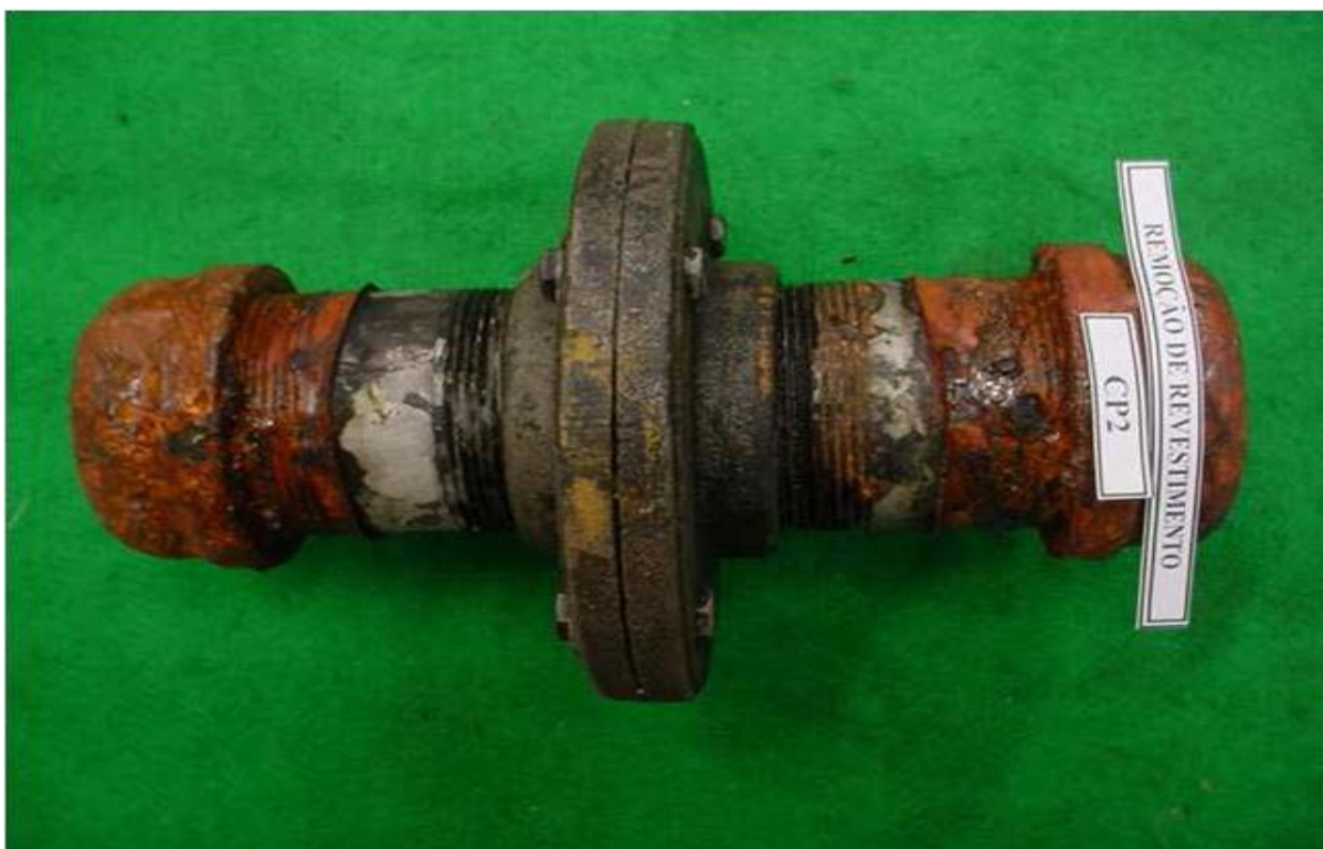
Figura 2 – aspecto geral do flange após remoção total do revestimento, após o período decorrido do teste no CENPES
