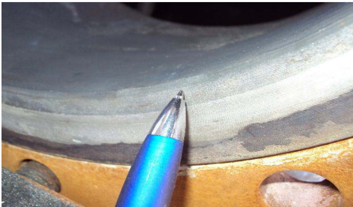
Figura 13: Boca de visita após 3 anos em operação, revestimento intacto
