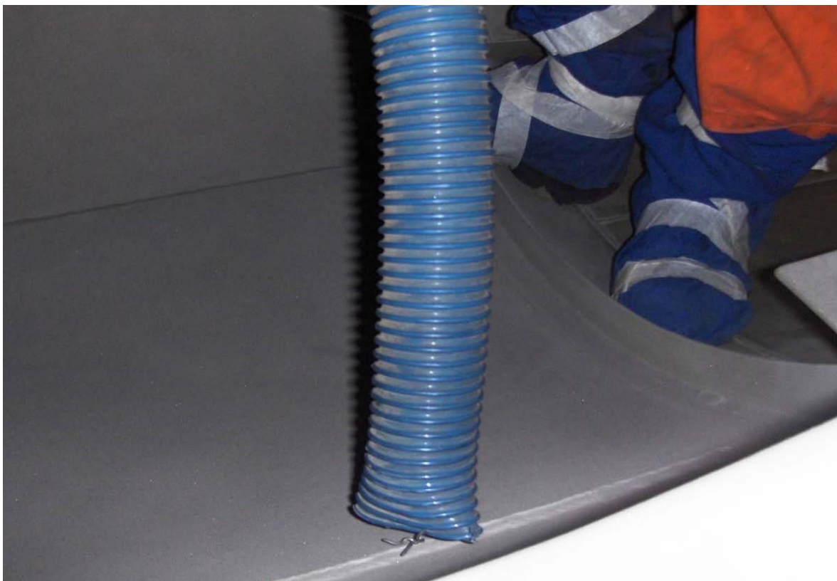
Figura 4: Aspiração do pó e resíduos após o jateamento, o cuidado com a utilização de pantufas para não contaminar o costado
