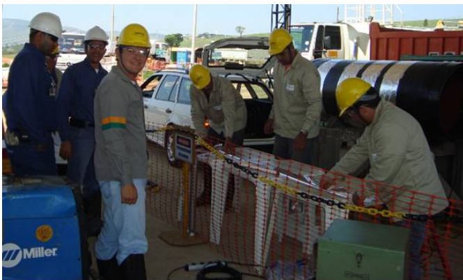
Equipe de campo do IPT e equipe da Fiscalização da Petrobras
