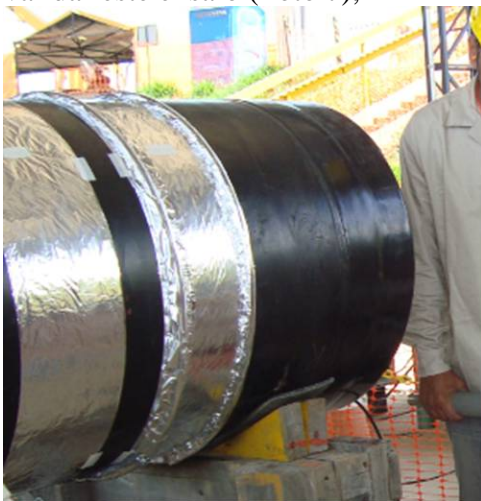
Foto 7. Extremidade do duto revestida com manta.
