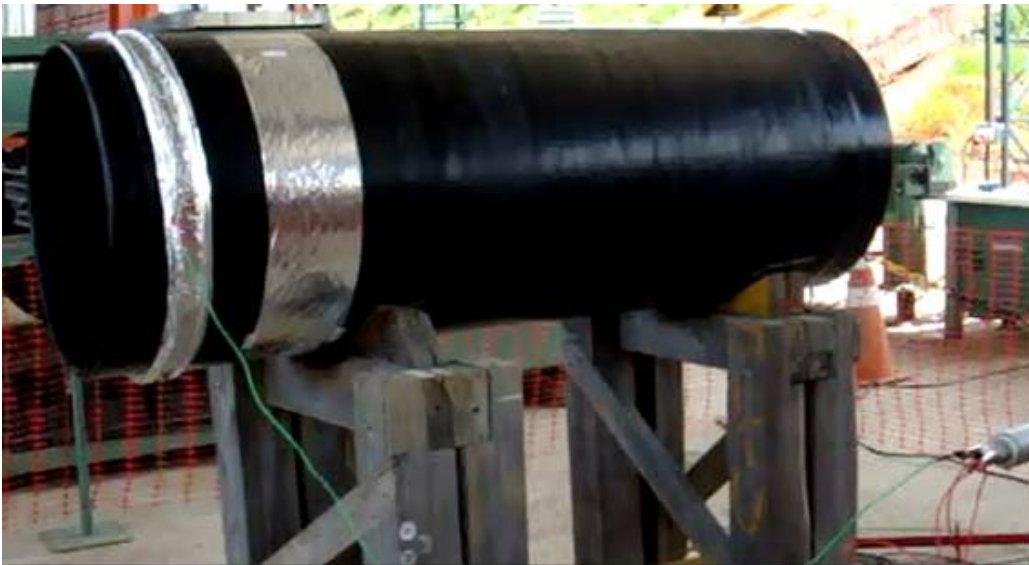
Foto 9 – Junta revestida com manta e sendo ensaiada
