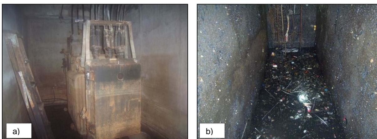
**Figure 1 - a) Transformador instalado em câmara subterrânea e b) Água residual contaminada com resíduos urbanos**
