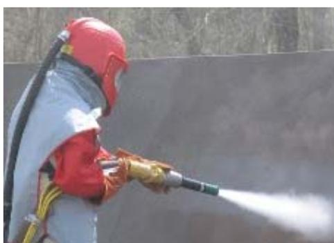
**Figura 1 – Preparación de un chapa de acero mediante el método de proyección de abrasivo.**
