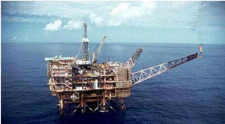
**Figura 1 – Plataforma fixa de produção localizada na Bacia de Campos – trecho emerso (topside)**
