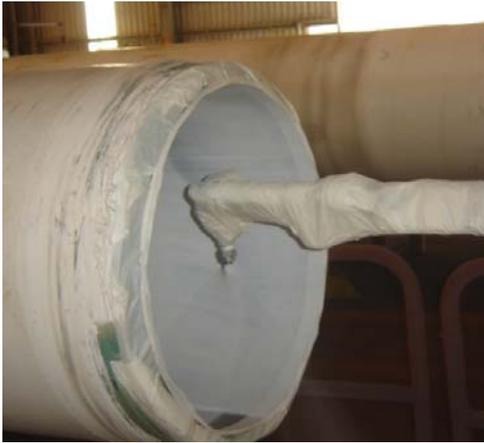
Figura 2 – Tinta sendo aplicada no interior do tubo.
