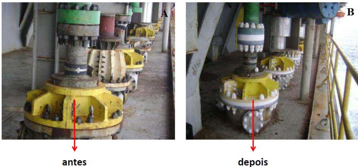
**Figura 9 – (a) uniões flangeadas desprotegidas de revestimento e (b) uniões flangeadas após a aplicação do revestimento.**
