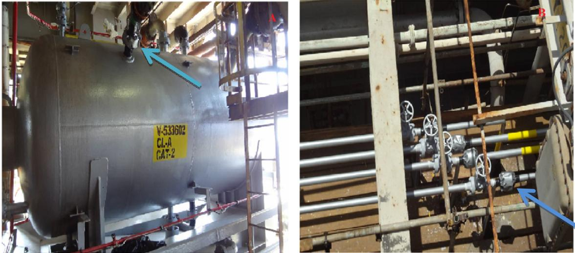
**Figura 11 – (a) proteção em uniões flangeadas do vaso separador e (b) utilização de capas poliméricas em válvulas de retenção**
