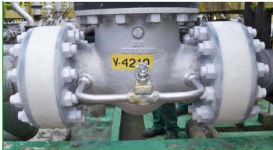
**Figura 2 - Revestimento constituído de resina à base de silicone em união flangeada de válvula**
