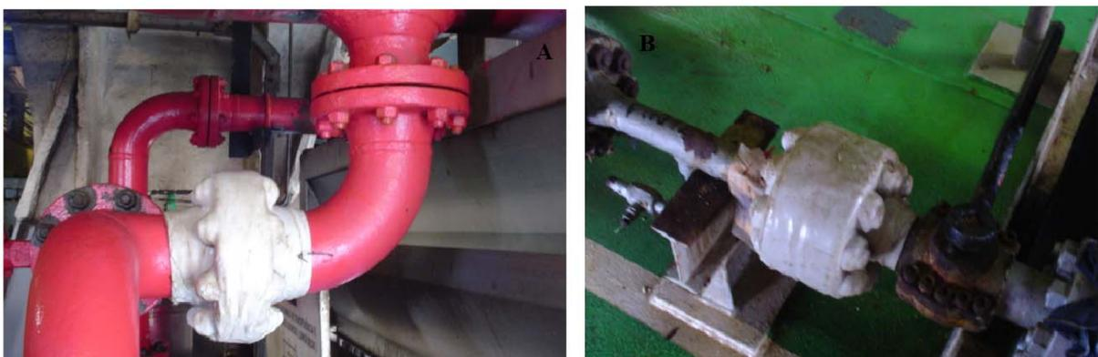
**Figura 7 – (a) flange do sistema de combate a incêndio e (b) proteção de flange do lançador de PIG.**
