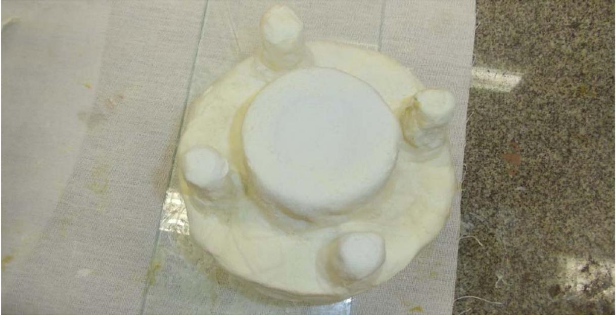
**Figura 5 - Fita anticorrosiva à base de hidrocarbonetos contendo microcristais de cera aplicado em uniões flangeadas.**
