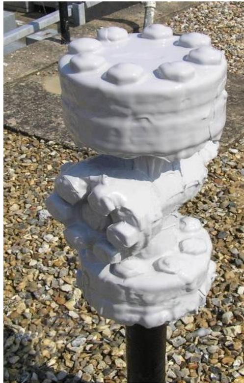
**Figura 1- Utilização do revestimento para proteção de uniões flangeadas**
