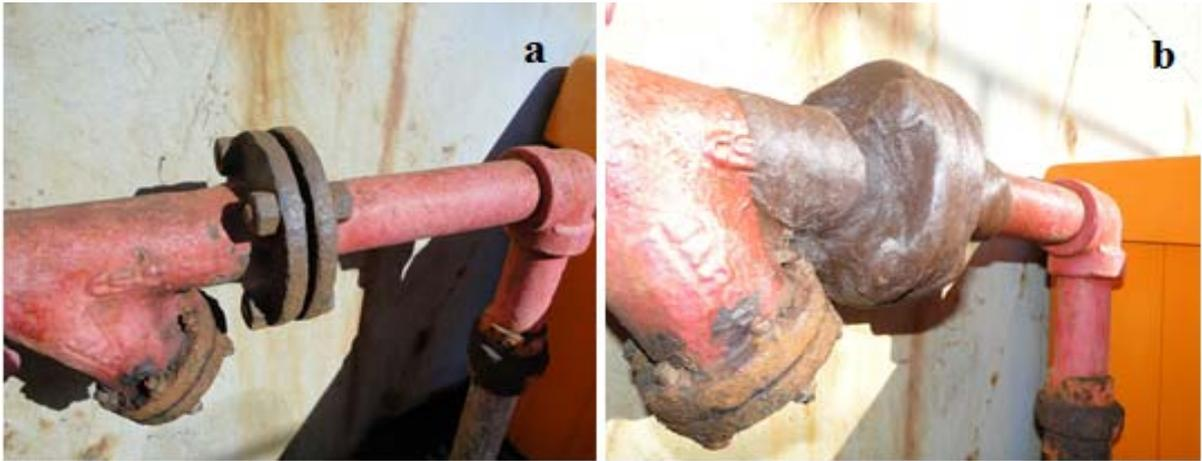
**Figura 15 – (a) união flangeada desprotegida, (b) união flangeada com aplicação da fita anticorrosiva.**
