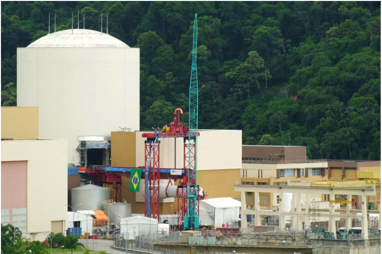
Figura 11 – Troca de geradores de vapor da Usina Nuclear de Angra 1.
