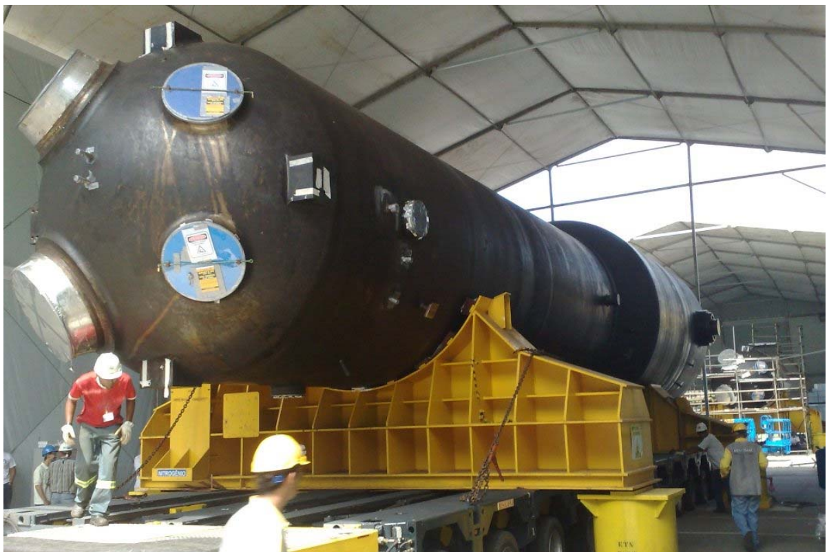
Figura 12 – Novo gerador de vapor da Usina Nuclear de Angra 1.
