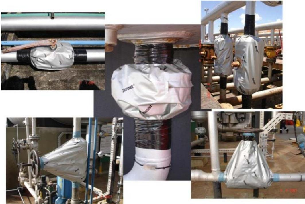
**Figura 5** – Várias Configurações de Instalações com as Capas do SPF
