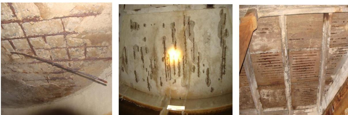
**Figura 1 – Fotos típicas de regiões com corrosão de armaduras**
