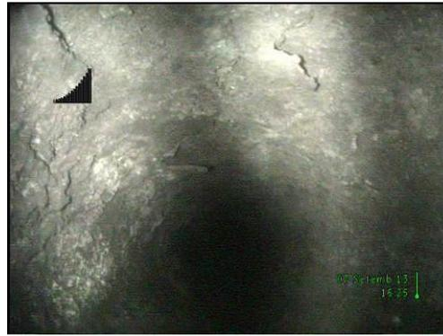
**Figura 12 - Presença de incrustação na superfície interna.**
