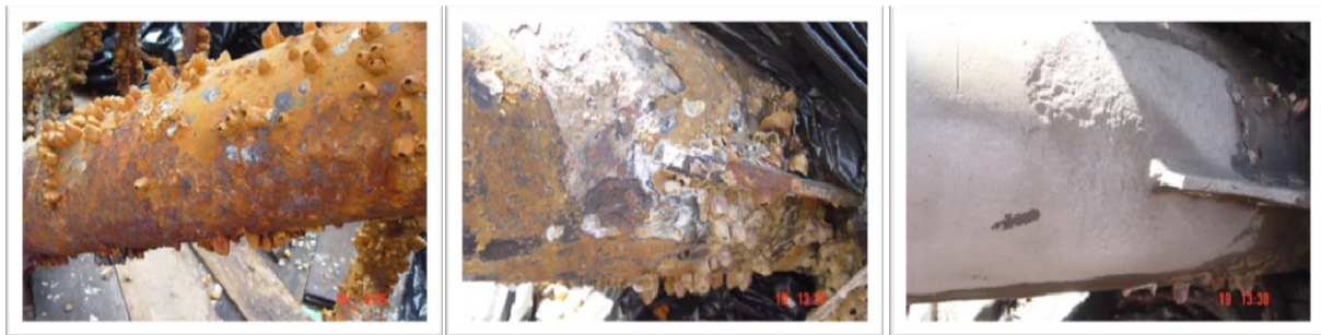
Figuras 1 a 3 - Preparação Superficial de Pernas de Plataforma (2)
