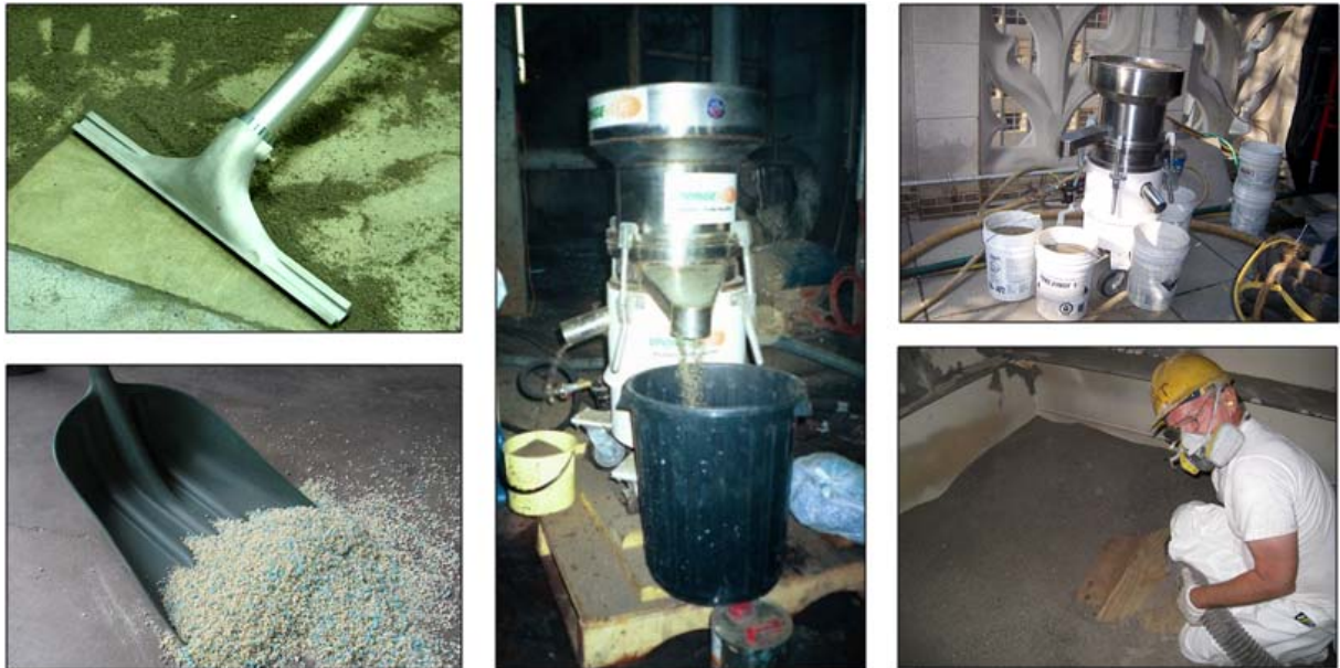
Figuras 13 a 17 - Exemplo de estrutura de coleta de esponjas para posterior reutilização por meio da Recicladora 35-P. Fonte: SPONGE-JET INC, 2012, Slide 34.
