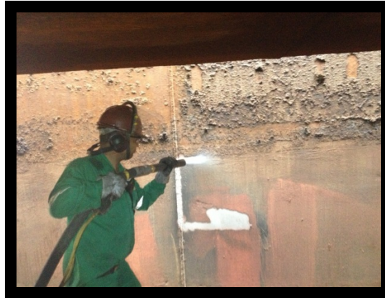
Figura 19 - Visibilidade do jateamento com esponja (17)
