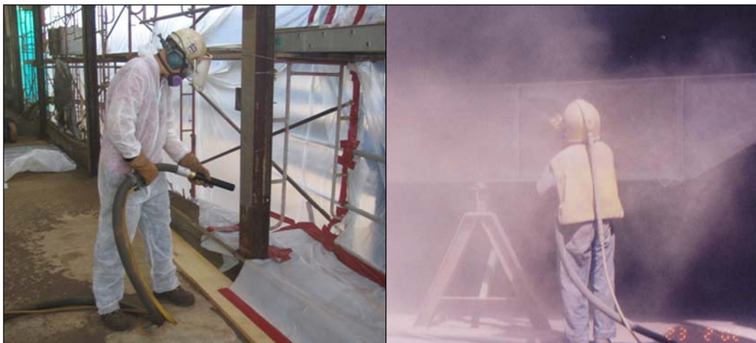
Figuras 10 e 11 - Comparação entre o Jateamento Abrasivo Convencional x Jateamento com Abrasivo Micro encapsulado em Esponja de Poliuretano (23)
