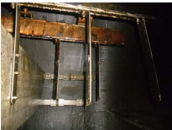
Figura 9 - Inspeção 2013, sem defeitos.
