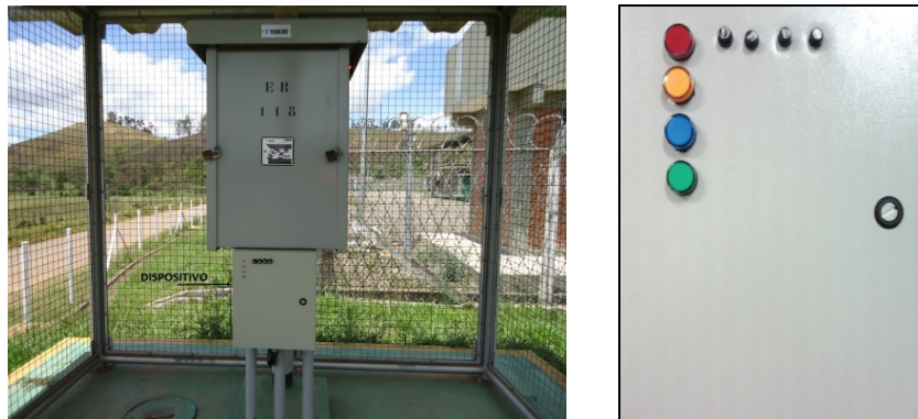
Figuras 7 e 8 – DCFR instalado e detalhe do dispositivo
