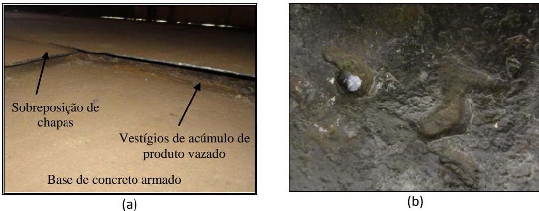
**Figura 1-** Aspecto visual de trecho com remoção de chapa de fundo de tanque, tendo-se exposição da base de concreto armado e de trecho de chapas sobrepostas, sob as quais há vestígios de produto vazado (a). Aspecto visual de trecho da face externa de chapa removida do fundo do tanque, tendo a mesma uma perfuração (furo com afunilamento de fora para dentro) e a presença de alvéolos (b)
