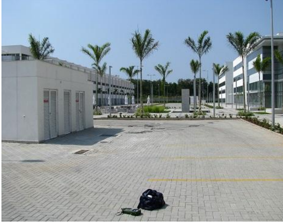
Fig. 03 – Vista Geral Interna da Área Atendida pelo Trecho 01
