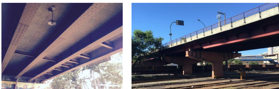
Figura 1 – Fotos do viaduto Nossa Senhora das Graças na cidade de Volta Redonda, RJ Fonte: Autor
