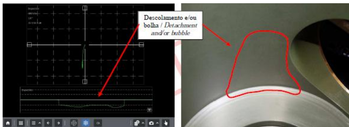
Figura 12: Defeitos por descolamento e/ou bolhas na parede interna do corpo da válvula 2.
