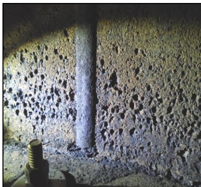
Foto 1c- pites no costado da coluna A, 1 a 4 mm de profundidade
