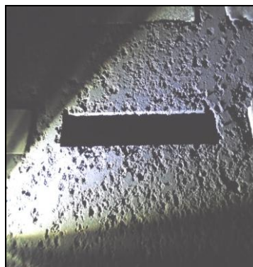
Foto 1d- pites e alvéolos na bandeja, coluna A
