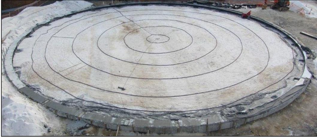
**Figura 6 – Vista aérea dos anodos concêntricos sendo instalados na base do tanque**
