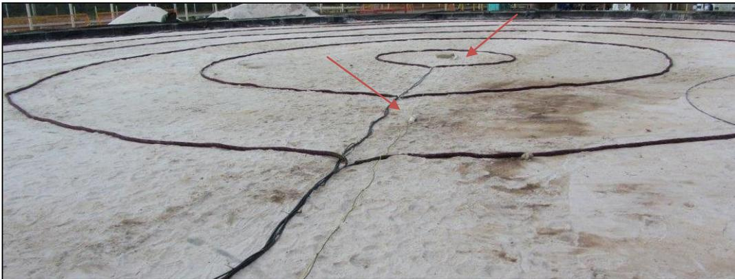
**Figura 7 – Detalhe dos eletrodos de referência instalados entre os anéis de anodos concêntricos**
