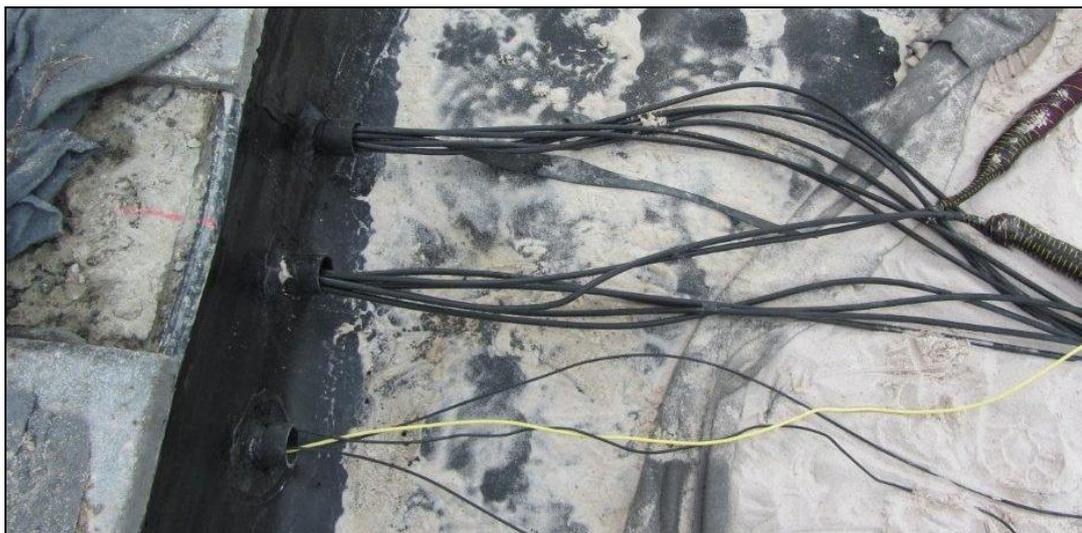
Figura 8 – Detalhe da passagens de cabos dos anodos e dos eletrodos de referência pelo anel de concreto da base do tanque
