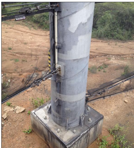
Figura 8 – Torre 10 – Galvanizadas a fogo
