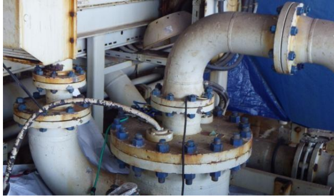
Figura 7: Conjunto de flanges antes da aplicação do polímero.
