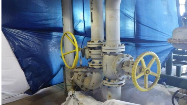
Figura 5: Preparação do local de aplicação.
