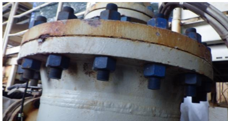
Figura 6: Flange preparado para aplicação do polímero termoplástico após limpeza.
