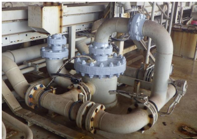
Figura 8: Vista ampliada do conjunto de flanges após aplicação do polímero termoplástico.
