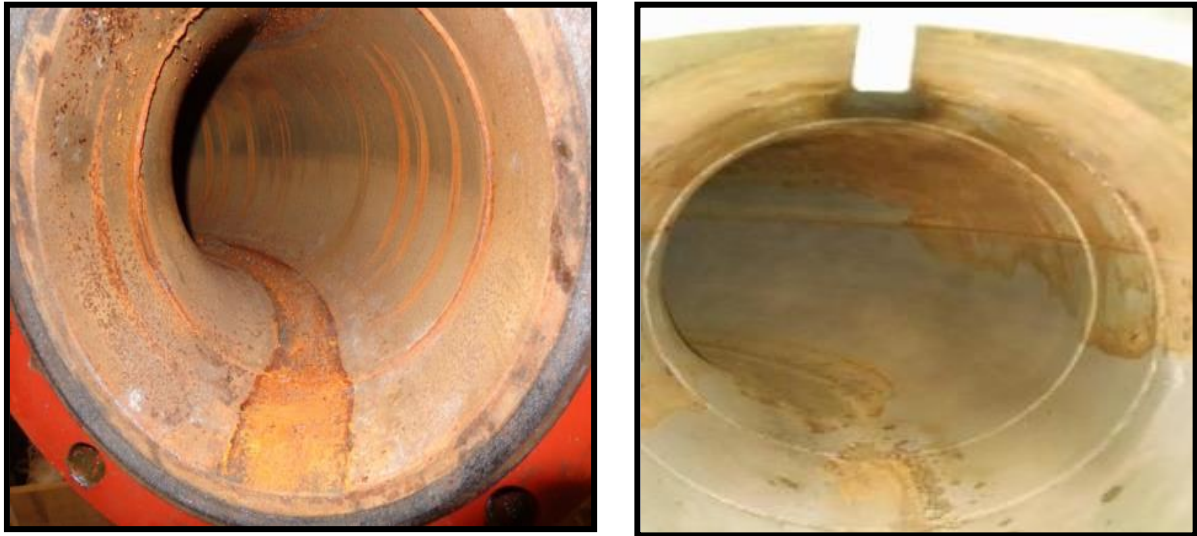
(a) (b) Figura – 10: Foto Linha de Sucção Compressores 8” AC: (a) Após abertura para inspeção; (b) Após limpeza química (retrabalho).
