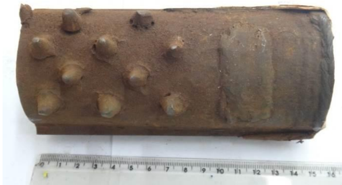
Figura 3 - Amostra 5: tubo usado da caldeira de recuperação com pinos onde foi feita a reposição da espessura por soldagem dentro da caldeira e que continuou em operação durante mais 1 ano.
