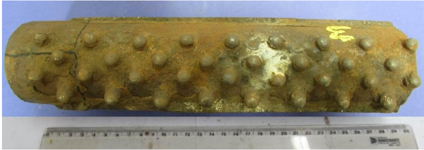
Figura 2 - Amostra 2: tubo usado com pinos que estava em operação na caldeira sem a reposição de espessura.
