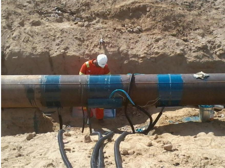
Figura 7 - matriz de pinos sendo finalizada, durante a montagem de intrumento FSM fabricado pela Emerson.
