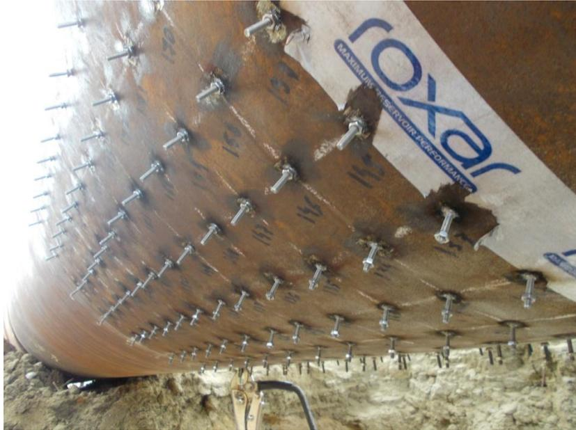
**Figura 6 - matriz de pinos sendo instalada, durante a montagem de instrumento FSM fabricado pela Emerson.**
