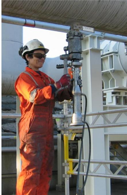
**Figura 17 - operação de troca de cupom utilizando equipamento do tipo hidráulico.**
