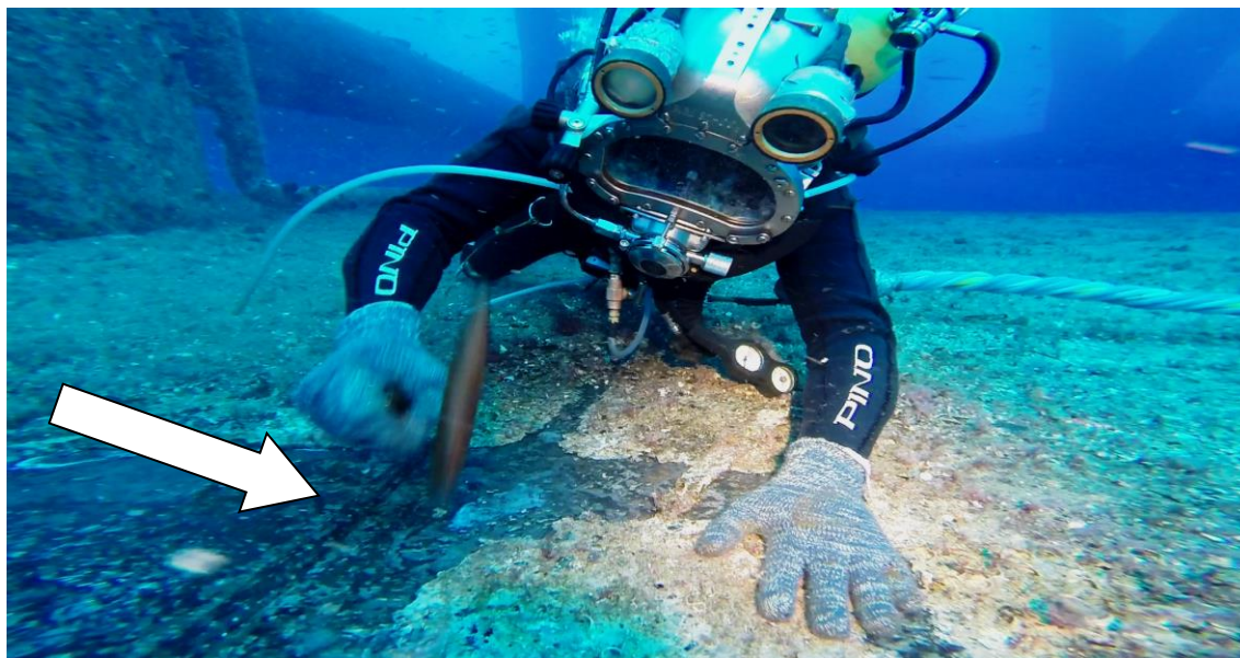
Foto 05 – Apresenta a operação da limpeza de incrustação.
