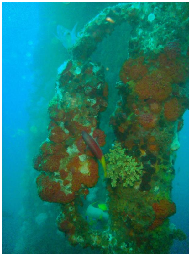
Foto 03 – Exemplo de incrustação em contraventamento e anodo a 30 m de profundidade.
