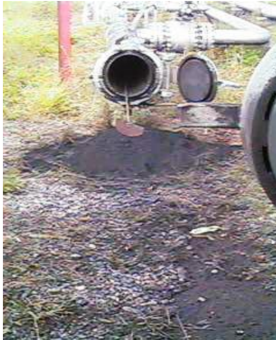
Figura 5 – Material formado por óxidos e siderita que foi retirado do recebedor após a passagem de um pig
