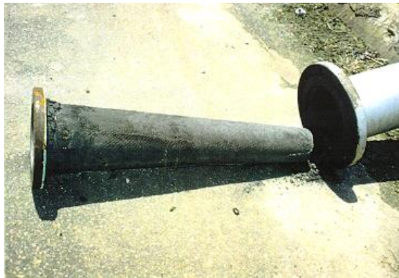
Figura 4 – Filtro de linha de gás com produto de corrosão do H 2 S, o qual entrou em combustão espontaneamente após alguns minutos exposto ao ar
