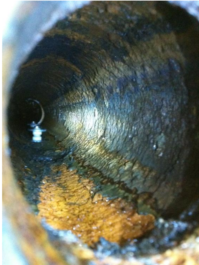
Figura 6: Vista interna da seção do tubo logo após a curva.
