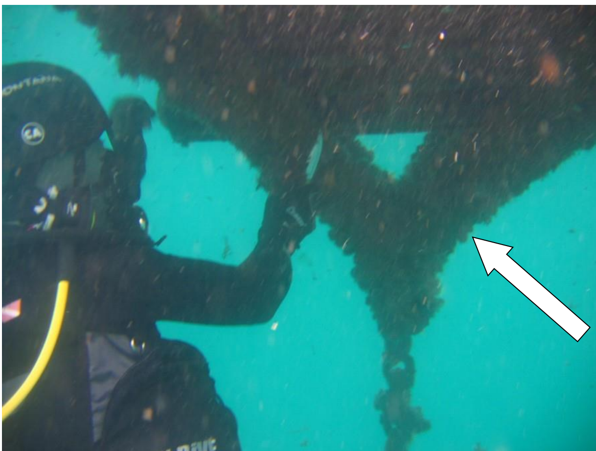
Foto 13 - Exemplo de estrutura submersa incrustada.
