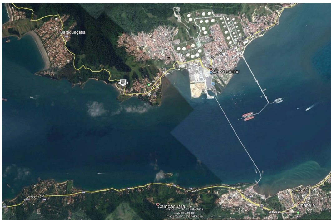
Foto 10 - A apresenta-se a imagem satelital do Terminal da Petrobras de São Sebastião.
