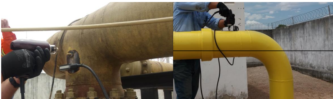
Figura 9: Solda realizada na vertical/horizontal
