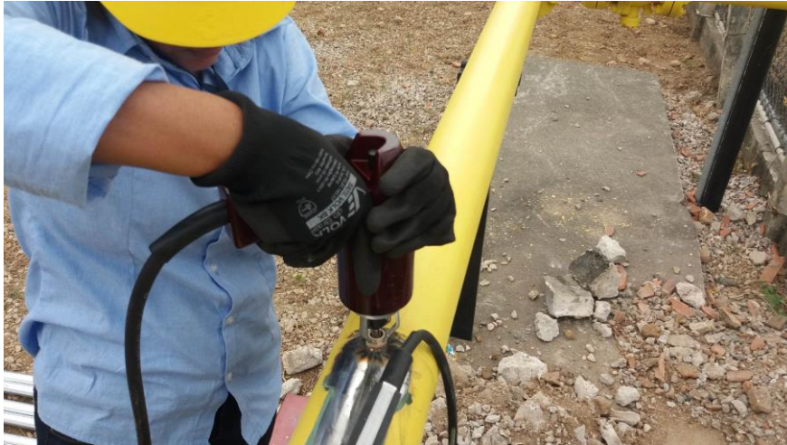
Figura 4: Aplicação da técnica “Pin Brazing”
