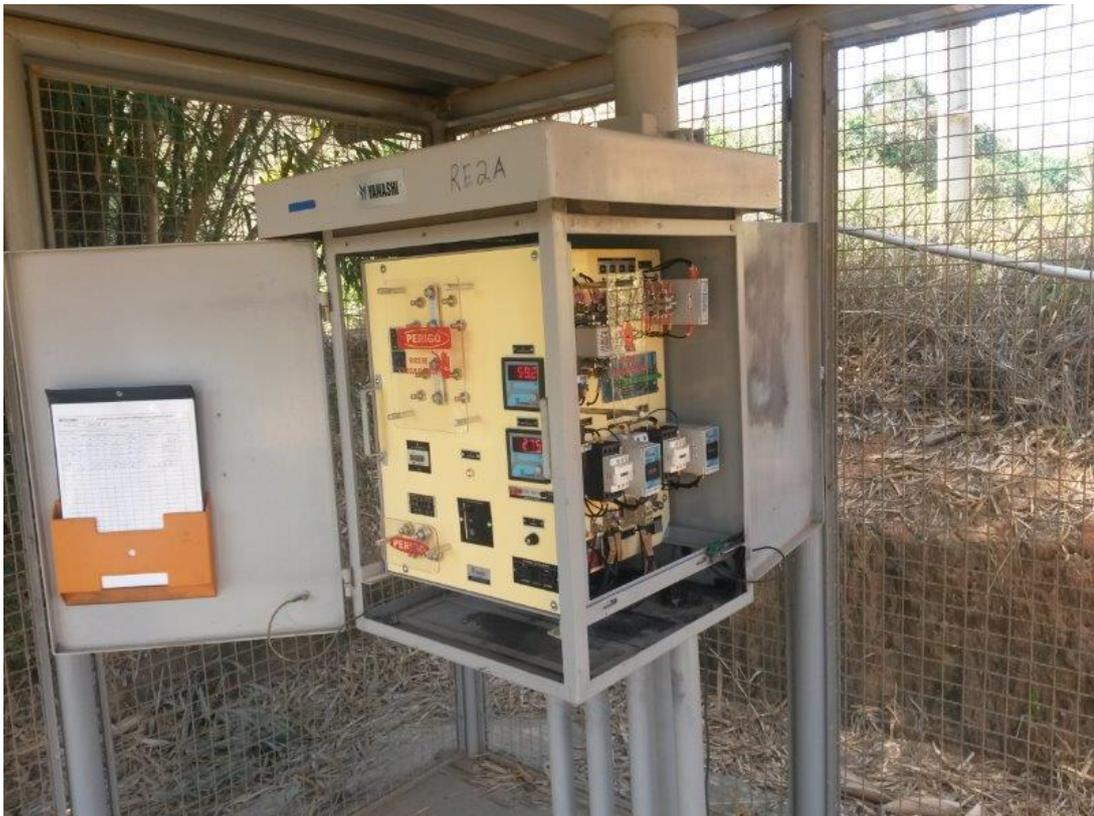
Figura 1 – Retificador de proteção catódica por corrente impressa
