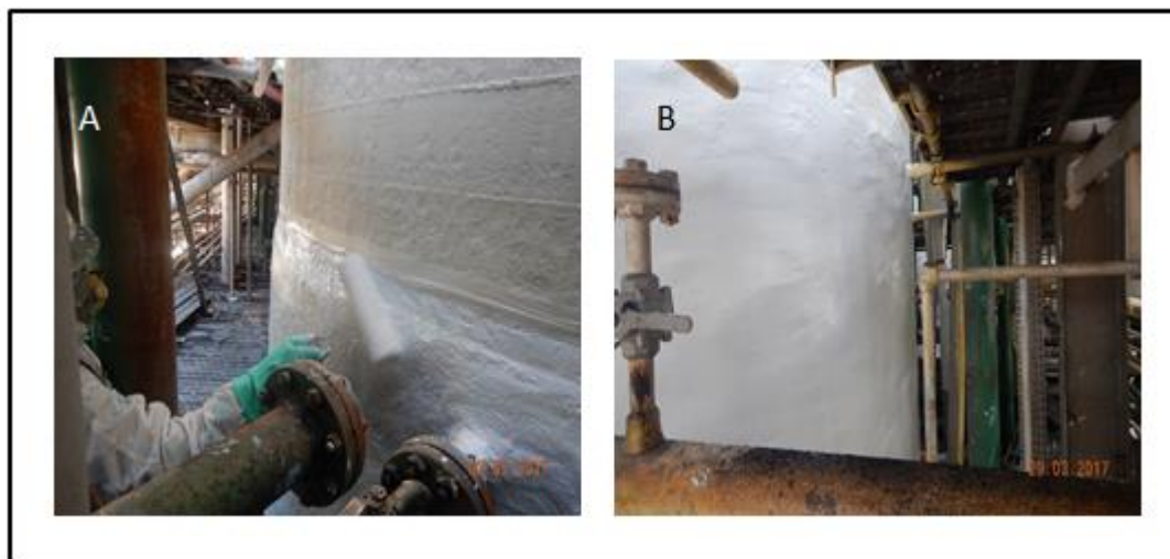
Figura 09 – Aplicação da demão de acabamento poliuretano (A) e superfície acabada (B).
