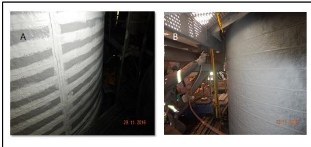
Figura 06 – Aplicação de demão de reforço (A) e fundo (B).
