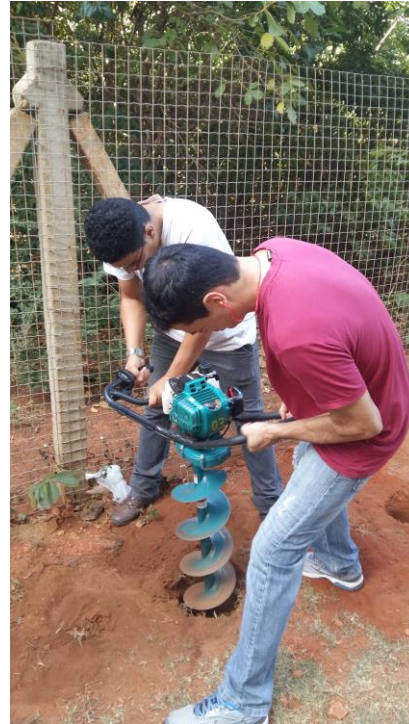
Figura 05 – Abertura dos furos para o enterramento dos corpos de prova metálicos
